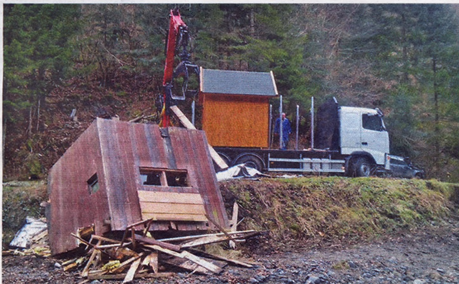
Micanje stare i postavljanje nove čeke
